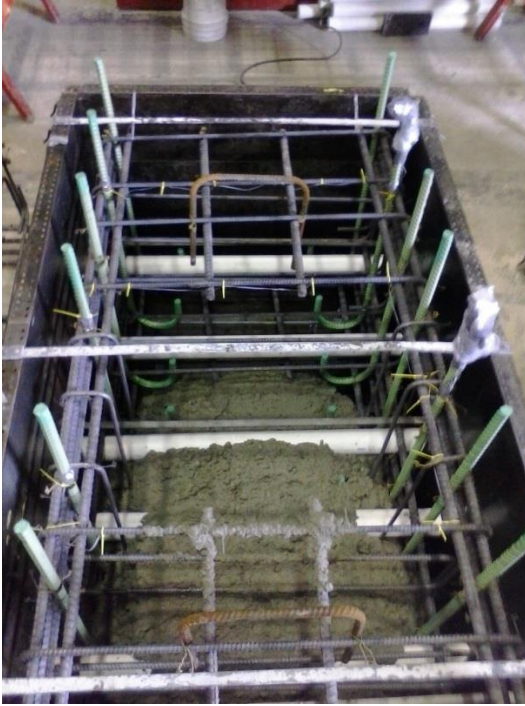
Figure 23. Pile cap rebar, formwork and pour
